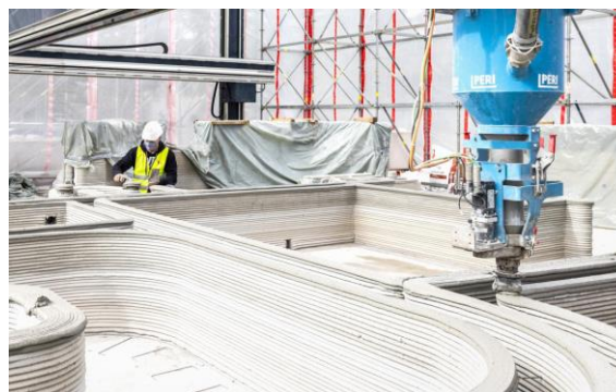
Sistema de impressão 3D aplicado à construção em arquitetura. Fonte: https://www.hsbcad.com/news/3d-printing-the-future-of-construction
