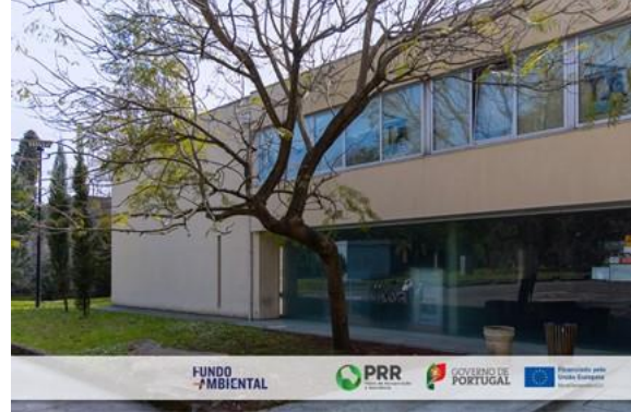
Reabilitação energética e ambiental do edifício FC6, do Campus FCUP.
